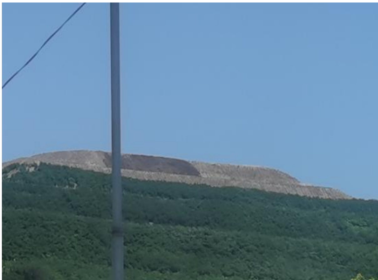
图 2.5-1 排土场现场照片
