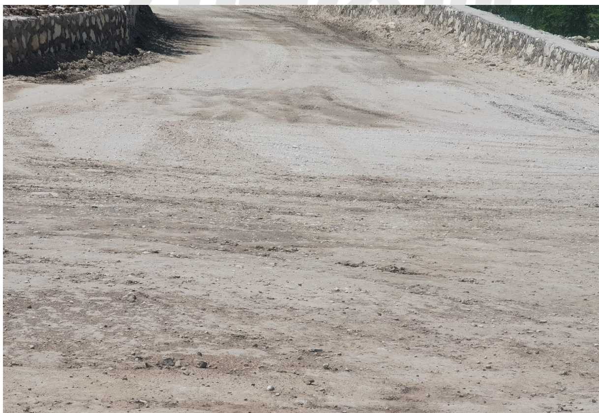
图 2.5-2 运输道路现场照片
