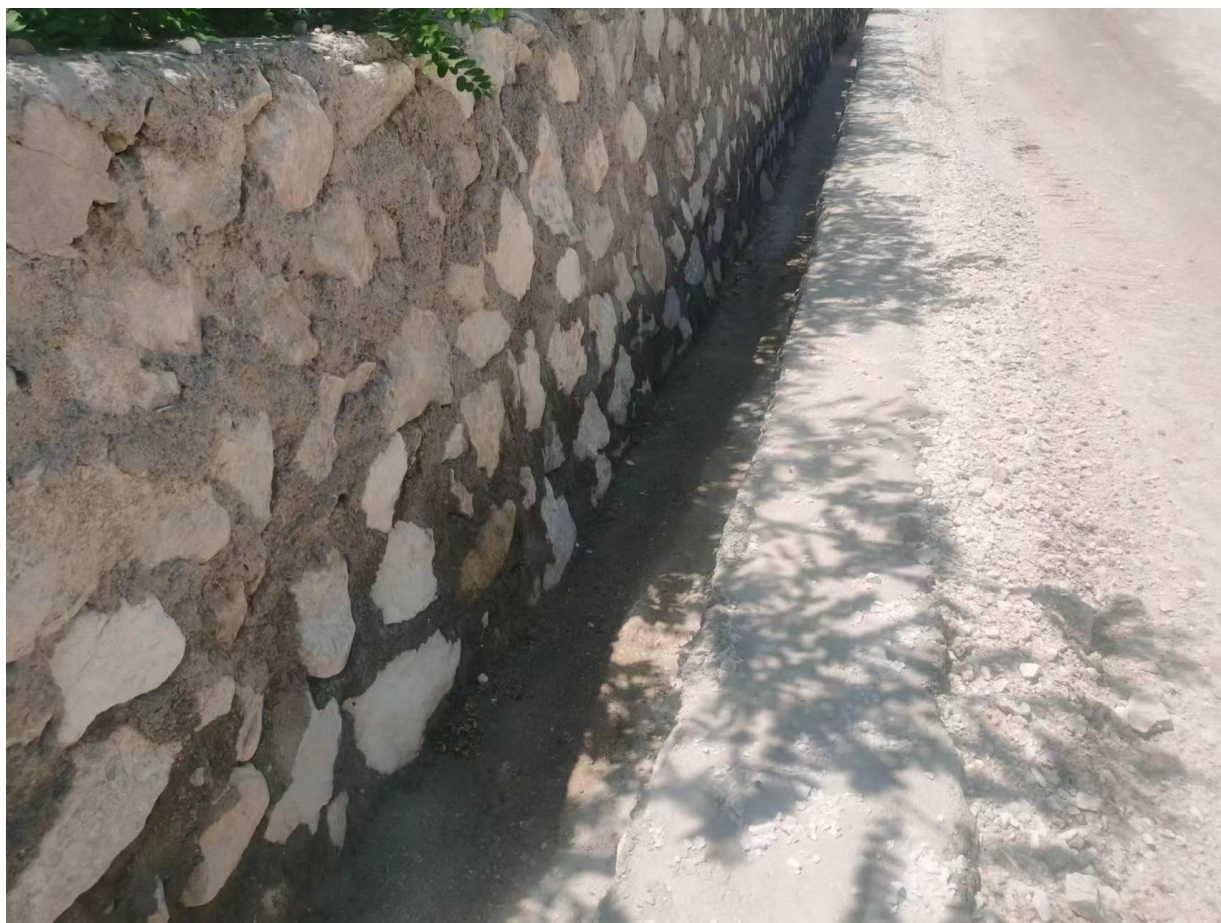
图 2.5-9 截水沟现场照片
