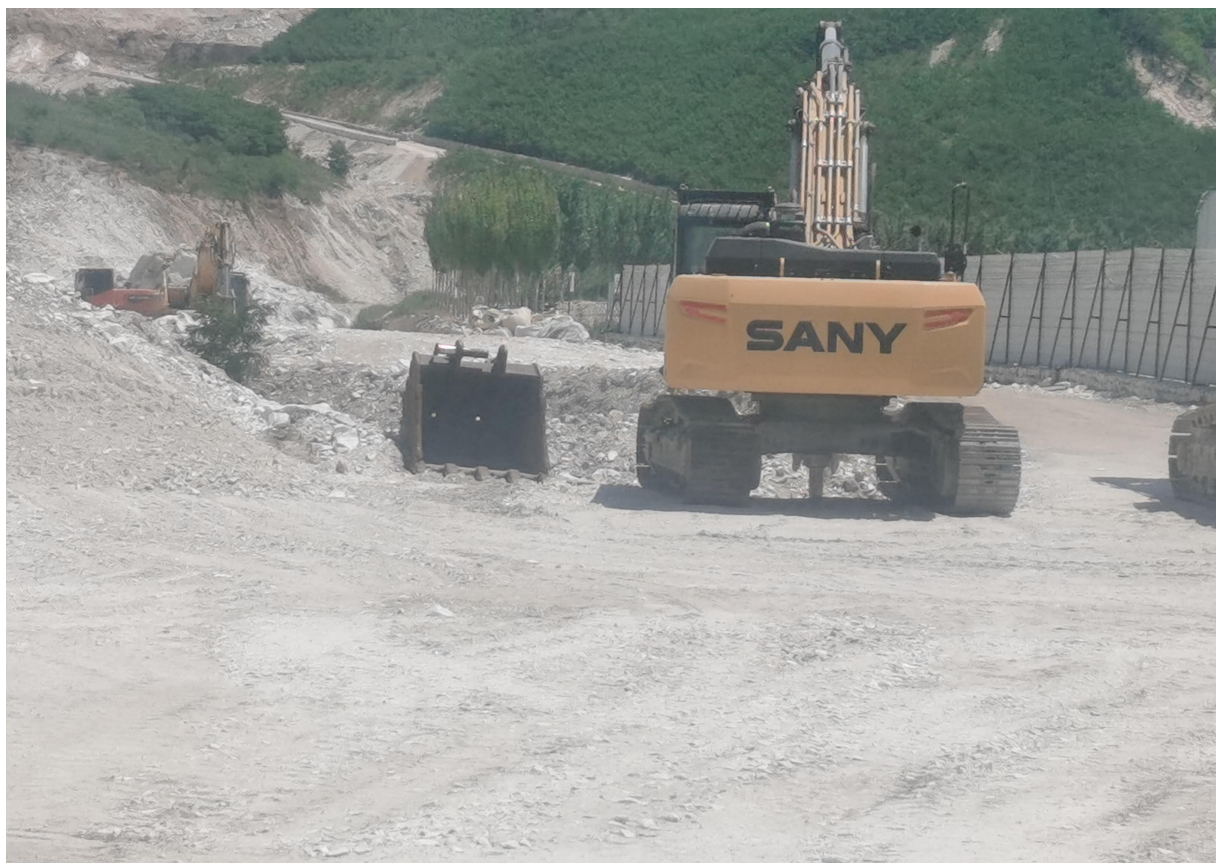
图 2.5-5 挖掘机现场照片
