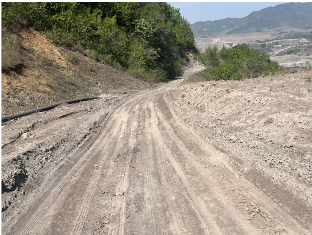
图 2.8-2 尾矿库上坝道路
